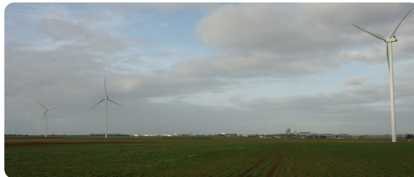
Parc éolien de TIPER
