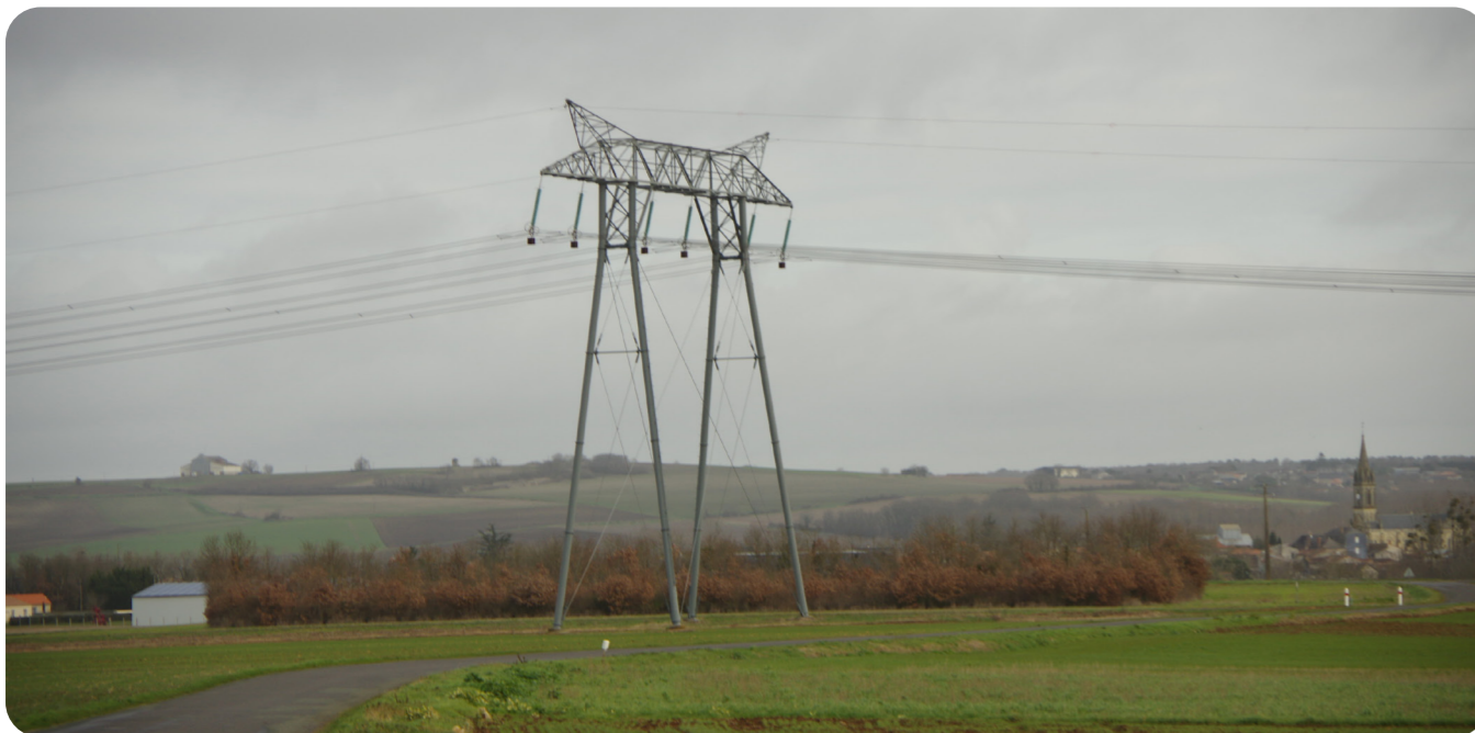
Pylône électrique faisant concurrence au clocher de Pas-de-Jeu
