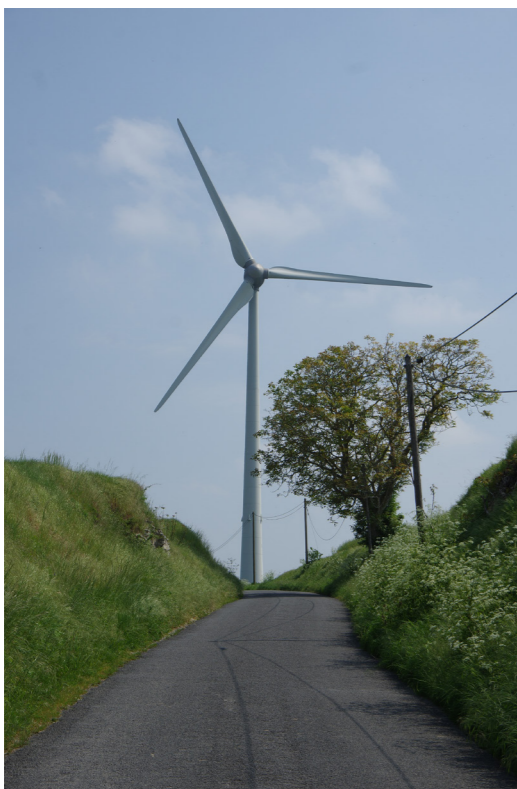
Éolienne du parc d'Antoigné
